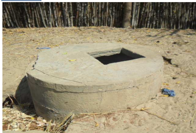
Cliché n° 5 : Puits communautaire
